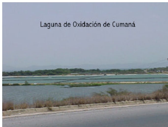
Foto 14.- Laguna de oxidación del sector Este de la ciudad de Cumará (Punta Baja). La misma fue afectada por el terremoto de 1997, y se encuentra en reparación desde entonces.
