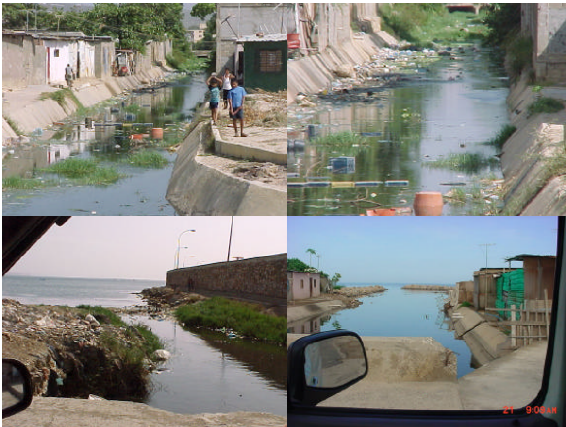
Foto 5.- En las fotografías pueden apreciarse diferentes drenes pluviales de la ciudad de Cumaná, los cuales descargan directamente en la zona costera. Estos drenes acarrean una gran carga contaminante, así como una gran cantidad de desechos sólidos que van a afectar la zona costera de la ciudad de Cumaná.
