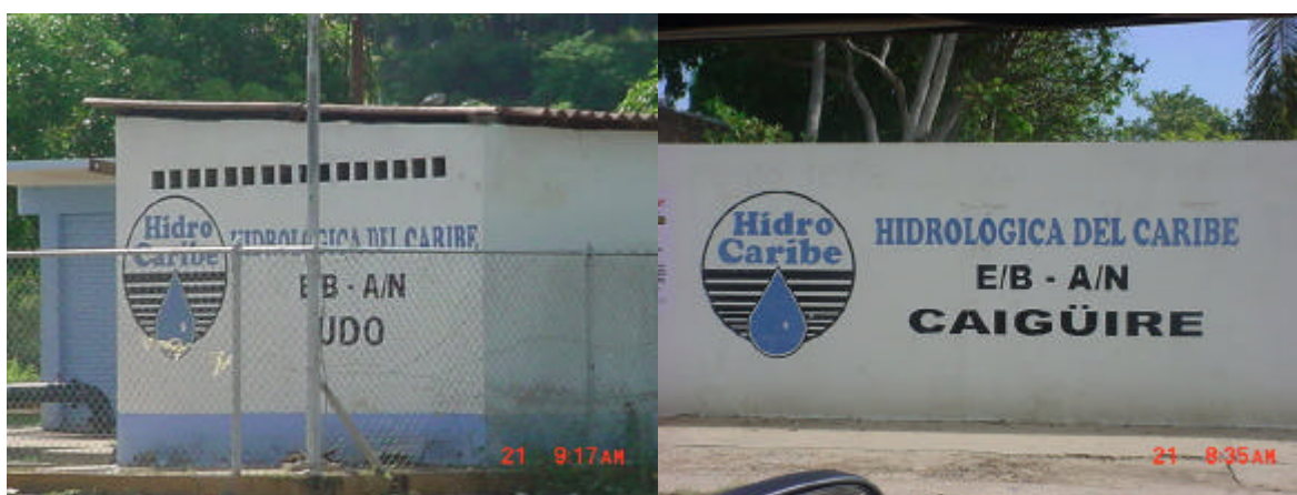
Foto 12.- Dos de las estaciones de bombeo existentes en la ciudad de Cumaná, una ubicada al Oeste de la ciudad (izquierda) y la otra al Este (derecha).
