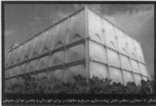
شکل ۶- مخازن بتنی قابل پدیده سازی سریع و مقاوم در برابر خوردگی و بعضی عوامل محیطی
